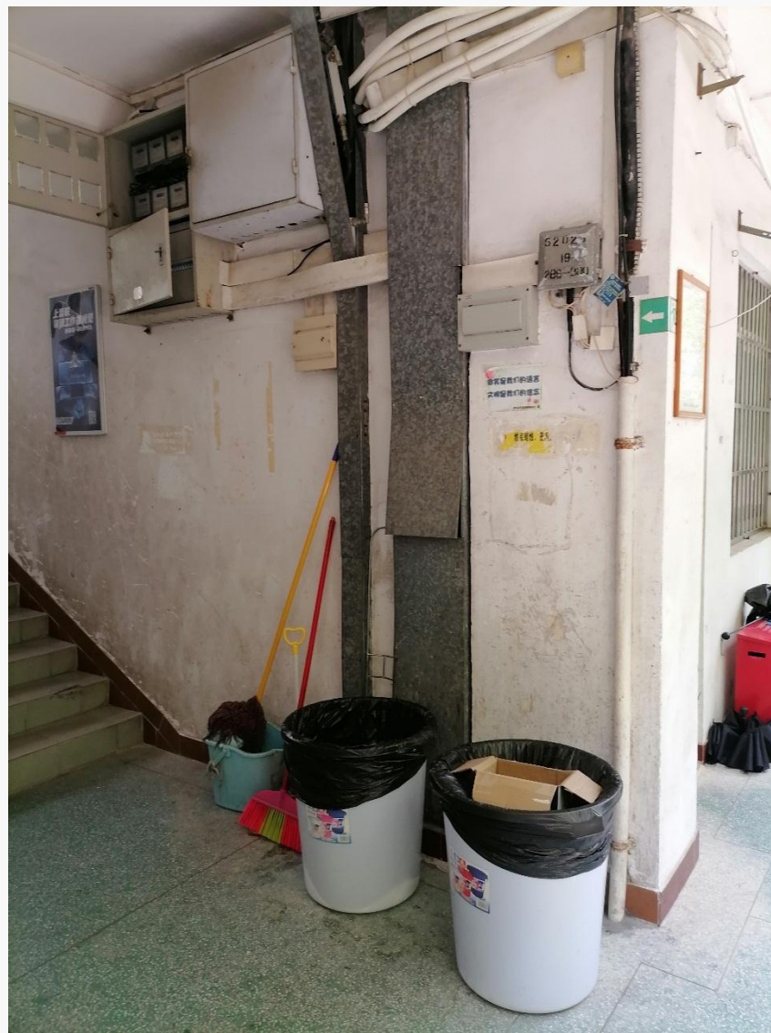
外走廊，有电梯，平面对垃圾收集点、热水站的空间和位置缺乏考虑，管线裸露
