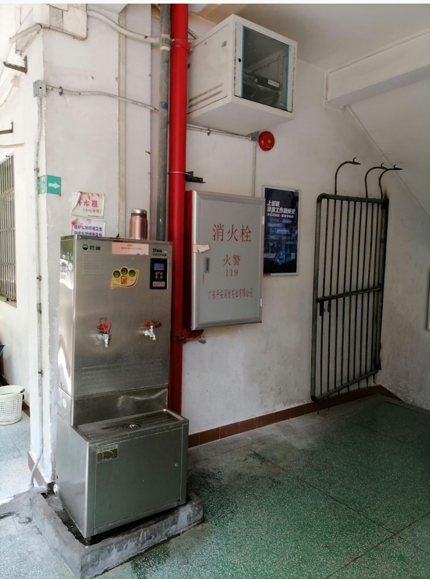
外走廊，有电梯，平面对垃圾收集点、热水站的空间和位置缺乏考虑，管线裸露
