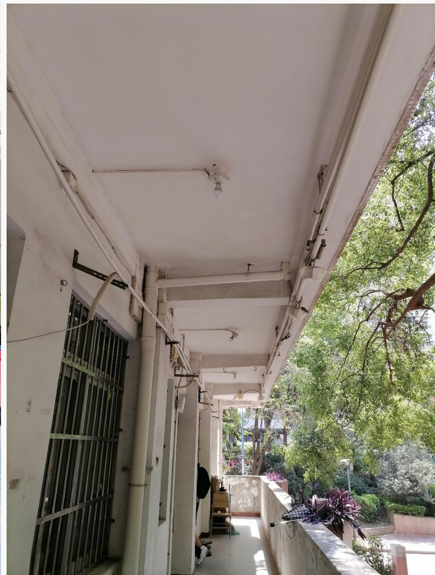
外走廊，有电梯，平面对垃圾收集点、热水站的空间和位置缺乏考虑，管线裸露
